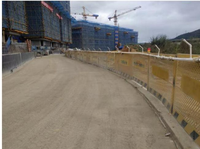
图：工地围挡喷淋降尘
